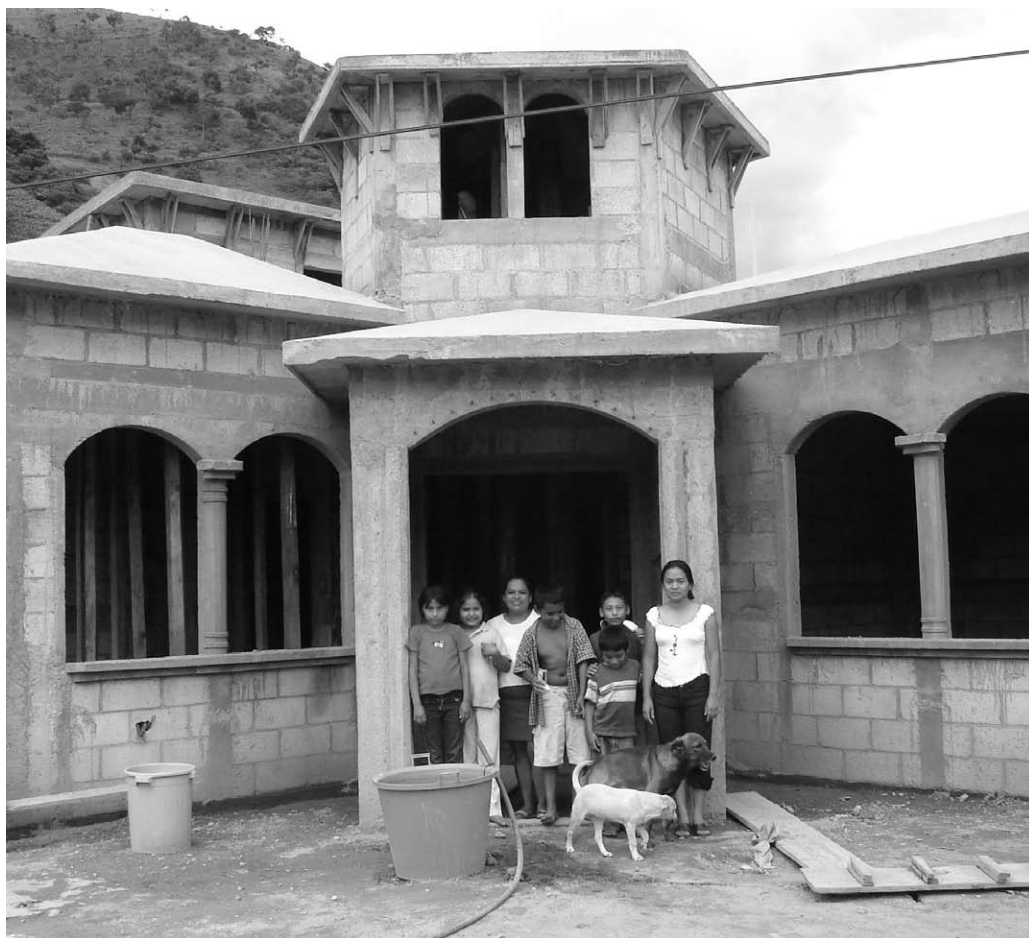
Casa en construcción gracias a las remesas obtenidas por mujeres en Florida con la venta de chuchitos. Santa Rita, Horno de Cal, Cuilco
